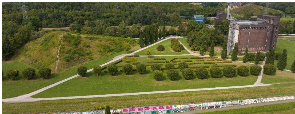
Der ehemalige Kohlebunker prägt das Bild der vergangenen Industriezeit © Foto: TU Dortmund / Uwe Grützner
